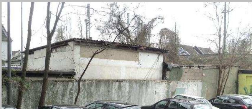
Mauer vor der Bemalung
