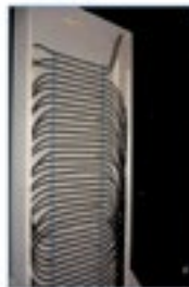
Rohrverlegung der Klimawand
