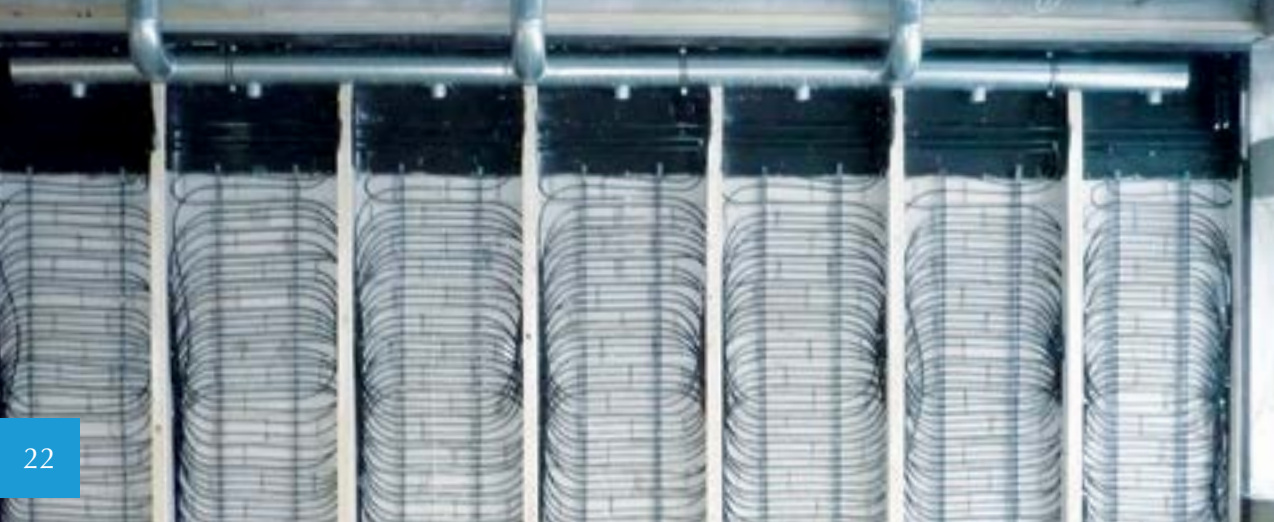
Klimawand im Bau ...
