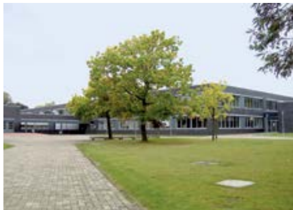
Vorbildlich sanierter Gebäudekomplex
