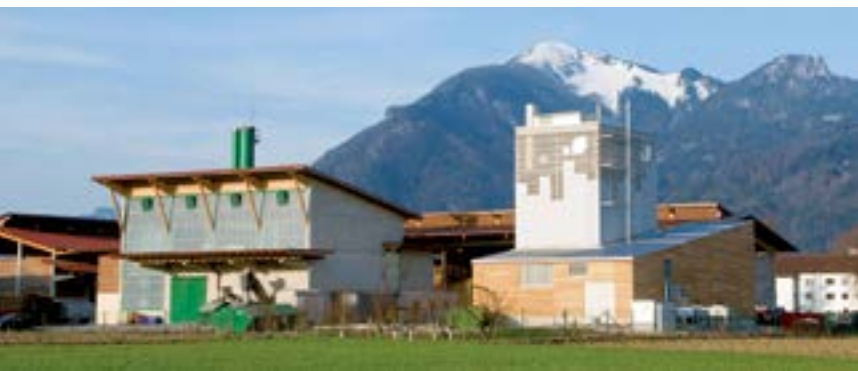
Heizwerk Grassau (links) und Heatpipe-Reformer (rechts)
