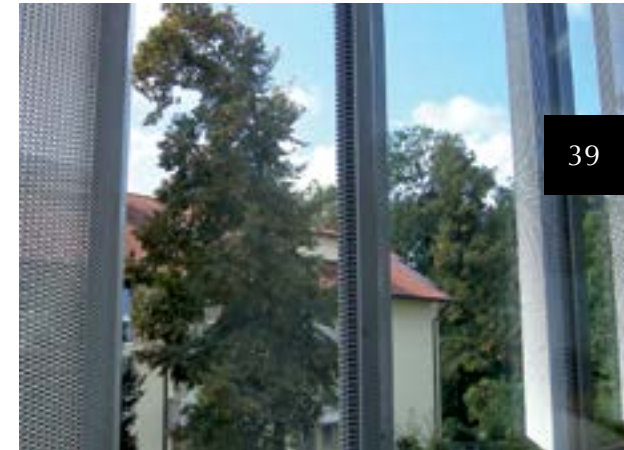
Metalllamellen regulieren Sonnenlicht und -energieeintrag. Ansicht von innen ...
