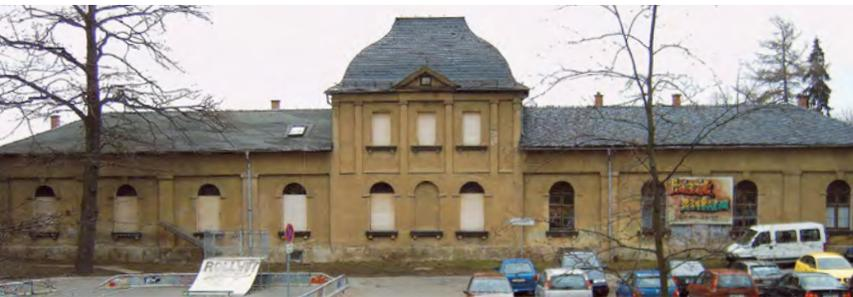
Auch die mit Naturschiefer gedeckte Dachkonstruktion sollte möglichst unverändert bleiben. Der Dachbereich des Nordflügels konnte aufgrund des guten baulichen Zustandes als Kaltdach belassen werden. Er erhielt eine neue Schieferdeckung und eine Deckendämmung. Die desolante Dachkonstruktion des Südflügels musste jedoch abgerissen werden. Als Ersatz wurde eine Stahlkonstruktion mit integriertem Oberlicht, Dämmung und Verbundholztafelkonstruktion als Warmdach realisiert.
