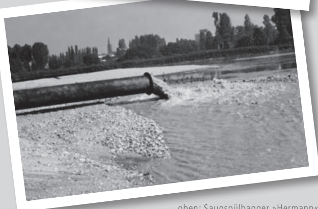
oben: Saugspülbagger »Hermann« unten: Spülfläche
