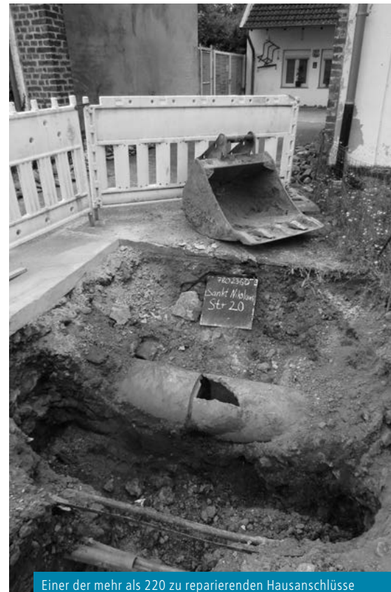
Einer der mehr als 220 zu reparierenden Hausanschlüsse
