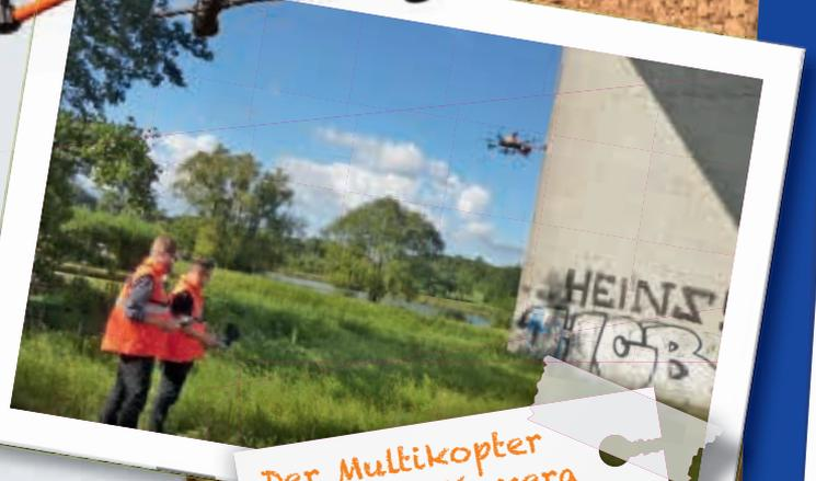
Der Multikopter sucht per Kamera Schäden an einer Brücke.
