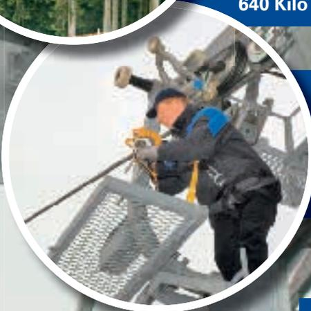
Die Sessel werden mit Reifenförderern durch die Station gefahren. Der Prüfer checkt die Sicherheitsschalter und Abstände.
