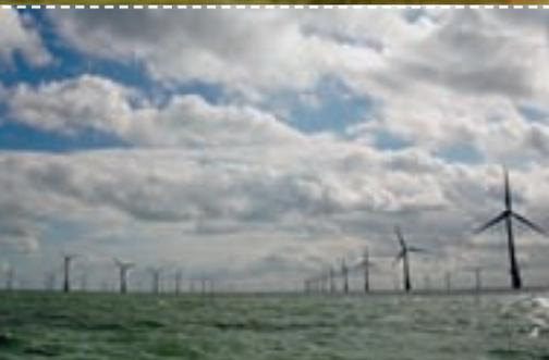
Der Offshore-Windpark Thanet liegt zwölf Kilometer nordöstlich der Themsemündung. Er besteht aus 100 Windkraftanlagen vom Typ Vestas V90 und wird von Vattenfall UK betrieben. Der Rotordurchmesser der einzelnen Anlagen beträgt jeweils 90 Meter; die Generatoren erzeugen eine elektrische Nennleistung von je 3 MW, insgesamt etwa 300 MW. Der Park steht auf einer Fläche von etwa 35 Quadratkilometern. Die Nordsee hat an dieser Stelle eine Wassertiefe von 20 bis 25 Metern.
