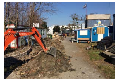
Strom-, Wasser- und Internetleitungen verlegen
