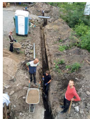
Leitungsbau, PLATZprojekt Hannover
