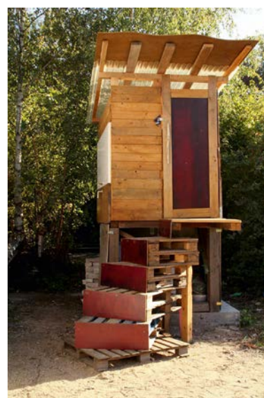
Gemeinsames Bauen am Fundament des Kompostklos © Carsten Beneker
