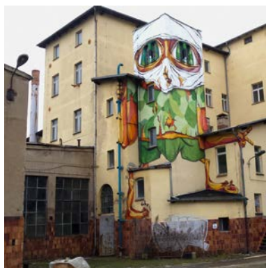
Die ehemalige Hefefabrik gehört zu den Industrieanlagen der Gründerzeit, die den Görlitzer Altstadt kern umschließen.
