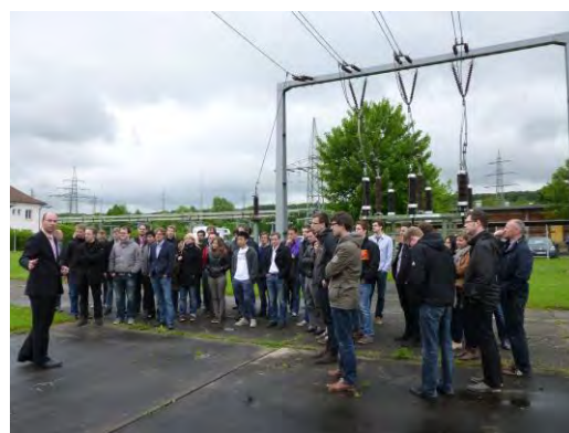
Abb. 3: Besuch Schaltanlage TransnetBW
