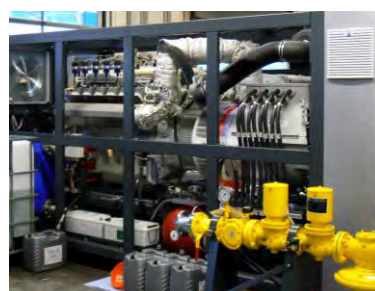
Abb.1: Geöffnetes BHKW
