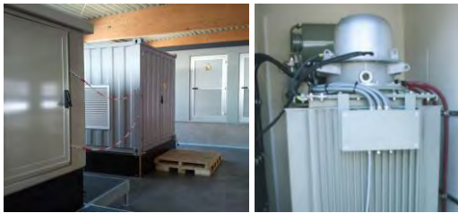
Abb. 1: Ortsnetzstationen und regelbarer Ortsnetztransformator (RONT)
