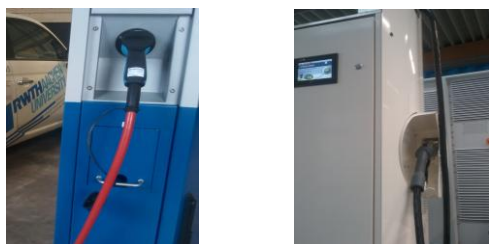
Abb. 2: AC Ladesäulen (Links) sowie DC-Schnellladesäule (Rechts)
