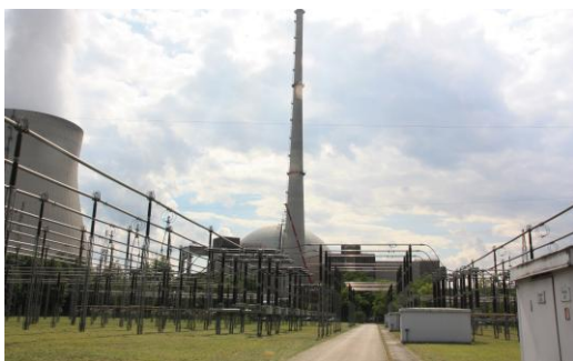
Abb.2: KKW Isar II mit Schaltanlage
