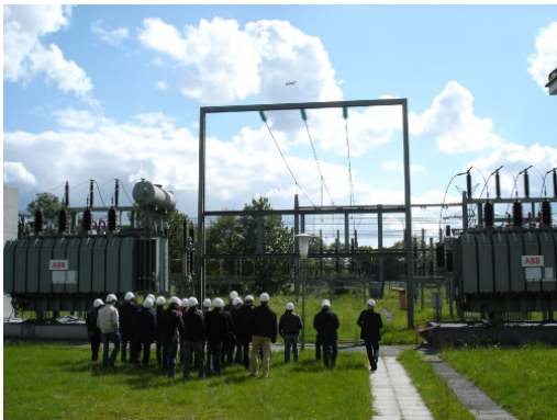
Abb. 3: Gruppenbild am Umspannwerk
