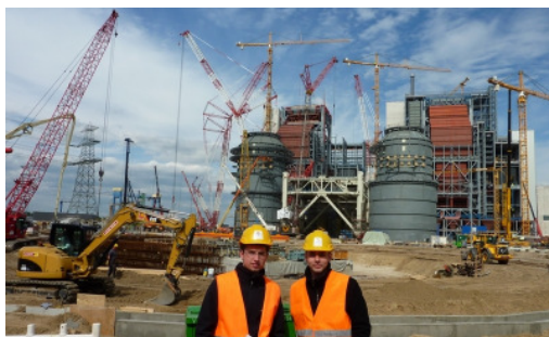
Abb. 6: Baustelle des Kraftwerks Moorburg
