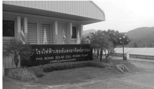
Photovoltaikkraftwerk in Mae Hong Son
