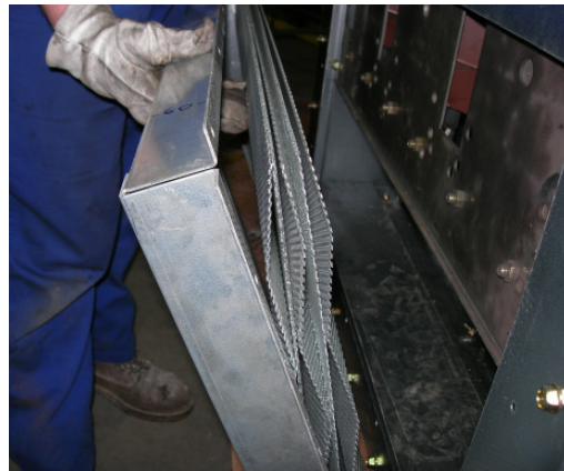
Abb. 2: Aufbau eines Energieabsorbers
