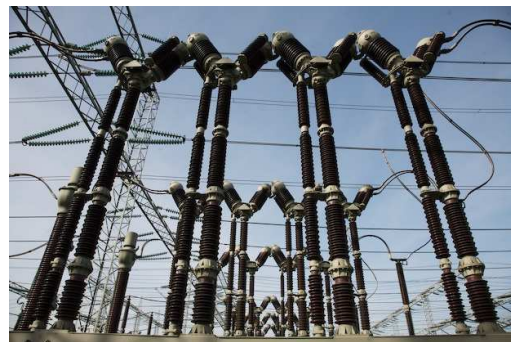
Abb. 2: Ölisolierter 380-kV-Leistungsschalter mit 8 Schaltstrecken
