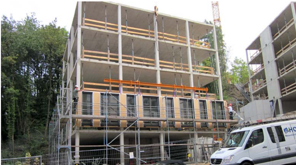
Abbildung 7: Montage vorgefertigter Holztafelelemente
