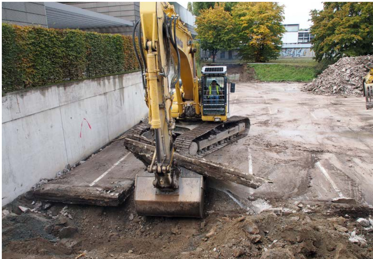
Untersuchungsobjekt 1 – Reißen der Bodenplatte
