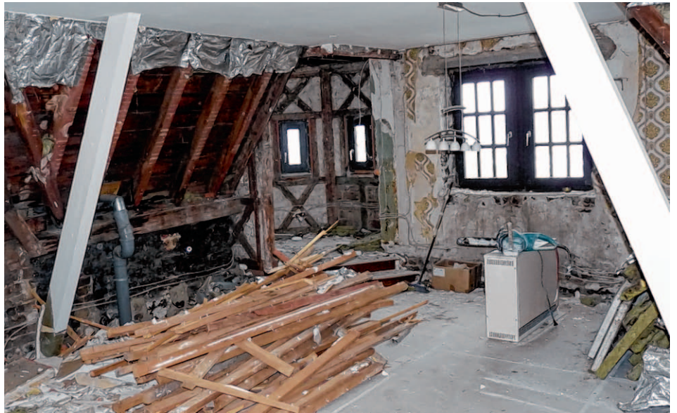
Die Hausmeisterwohnung von Dirk Rombach ist noch eine riesige Baustelle. Foto: Stadt
