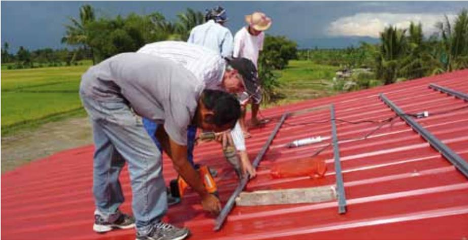
*Regenerative Energien: Umweltschutztechniker Alois Josef Werner mit philippinischen Monteuren bei der Befestigung des Unterbaus für Solarpaneele*
