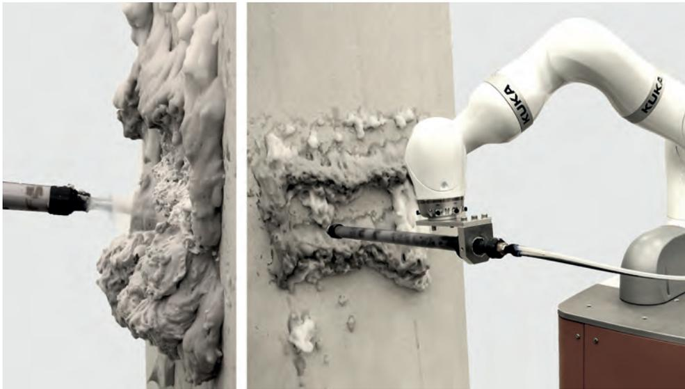
Bild 7: Tests zu Verarbeitungstechniken von wärmedämmendem Schaumbeton, entwickelt am Institut für Bauforschung ibac (oben). Auftragen des Schaumbetons mittels Spritztechnik auf mobiler Roboterplattform (unten).
