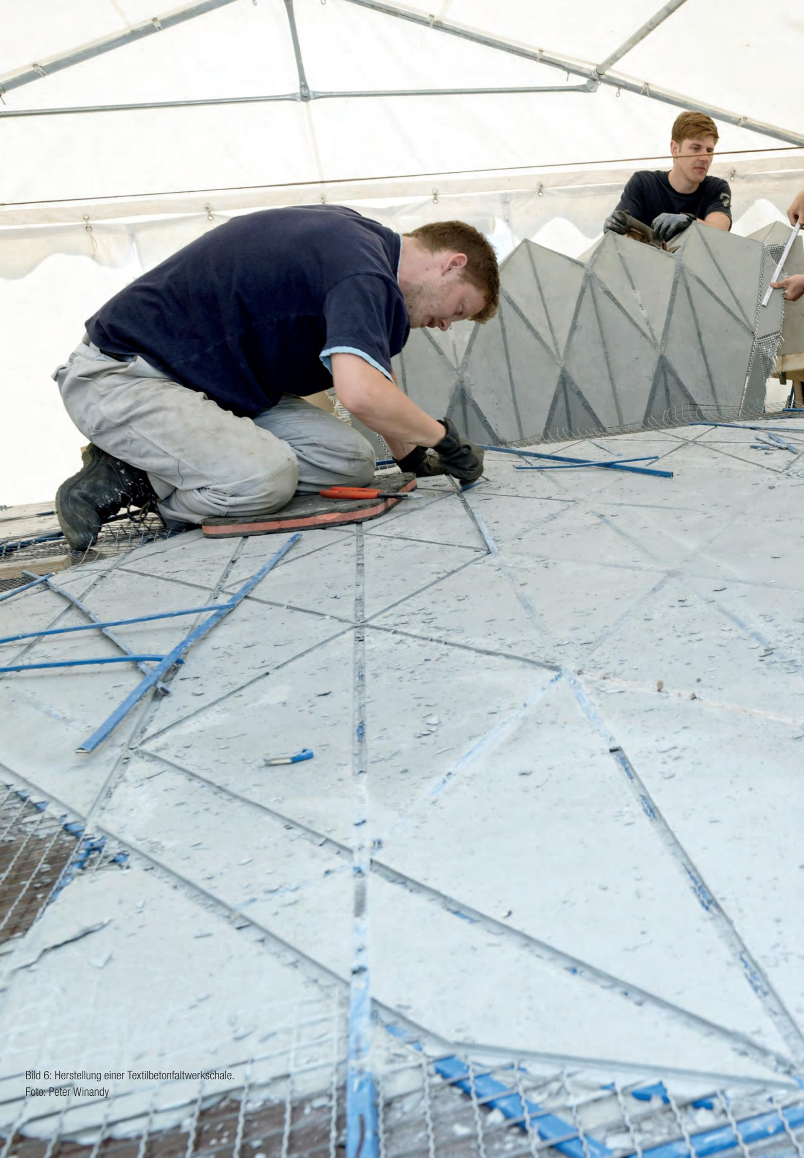
Bild 6: Herstellung einer Textilbetonfaltwerkschale.
