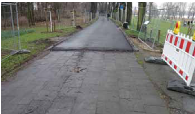
Niederländer Ufer: Auf zwei Kilometern wurde der beliebte Abschnitt des Rheinradwegs saniert. Auf die alte Plättierung wurde eine ebene und komfortable Asphaltschicht aufgebracht.
