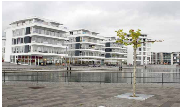
Grimme-Preis für den Dokumentarfilm „Göttliche Lage“: Auf dem ehemaligen Werksgelände Phoenix-Ost im Herzen eines Arbeiterviertels entsteht eine luxuriöse Wohnanlage.
