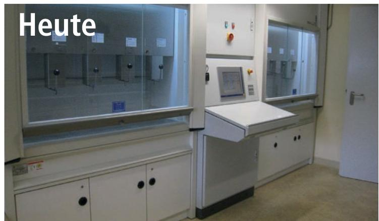
Seit 2007 ist die Chemikalienausgabe im aufwändig kernsanierten Lösemittelbunker in Betrieb. Die vorher mit Handpumpen abgefüllten Lösemittel, sind nunmehr an eine computergesteuerte Abfüllanlage angeschlossen. Abfüllung und Lagerung sind räumlich getrennt.
