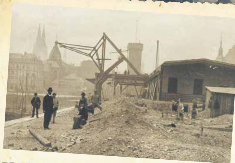
Eine Aufnahme aus der Bauzeit des Rheinauhafens, der 1898 eröffnet wurde.
