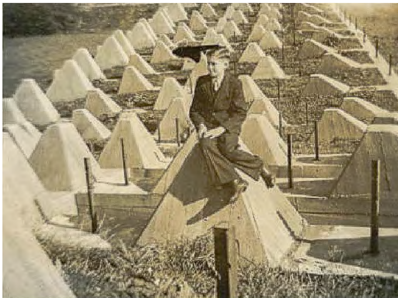
Füngzeilige Panzersperre (mit Georg Johnen) vor der Dreilägerbachtalsperre, das Foto von 1939 zeigt die gerade fertiggestellte Höckerlinie. Roetgen, Westwall
