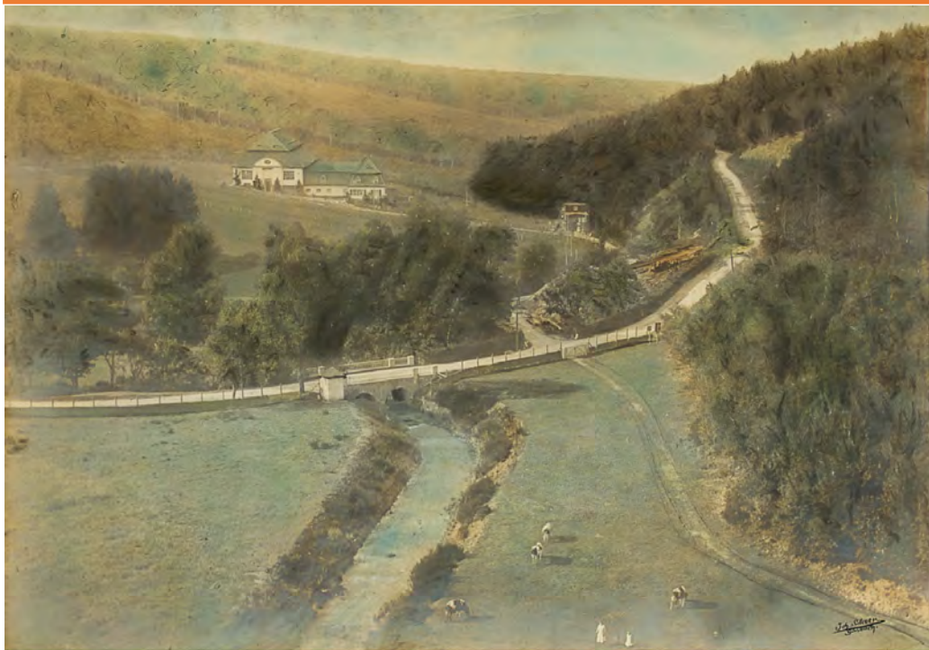
Das Gelände vor der Sperrmauer der Dreilägerbachtalsperre in Roetgen kurz nach der Fertigstellung 1912 Roetgen, Dreilägerbachtalsperre
