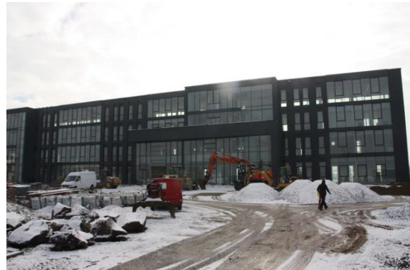
Eisenbahnunternehmen TX Logistik AG (Airport Gewerbepark Junkersring)
