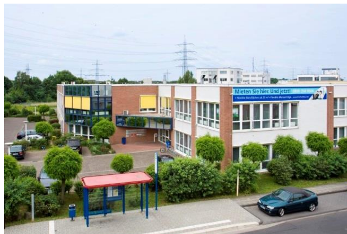
Businesscenter Mottmannstraße 1-3 (Quelle: TROWISTA GmbH)
