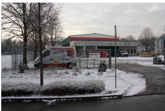
Karosseriebau Heidinger GmbH (Speestraße 28)
