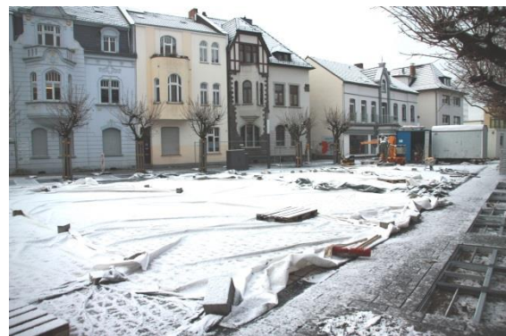
Bauarbeiten am Fischerplatz (Quelle: TROWISTA GmbH)
