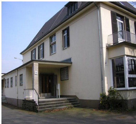
SB Entwicklung GmbH & Co. KG im Gebäude der ehemaligen DN-Weiterbildung (Geb. 107) an der Mülheimer Straße
