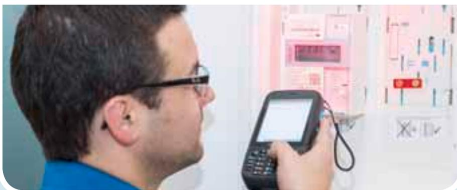
Moderne Zähler haben auf ihrem Etikett einen QR-Code. Ihn kann man einscannen und hat alle relevanten Daten auf dem kleinen Handgerät. Sie lassen sich in das System der Stadtwerke Düren integrieren. So funktioniert modernes Zählermanagement.
