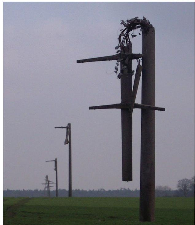
Abbildung 29: Masten einer Mittelspannungsleitung im Münsterland, die im Winter 2005 durch Schnee- und Eislasten abgeknickt wurden (Quelle: Wikimedia Commons/Stahlkocher).
