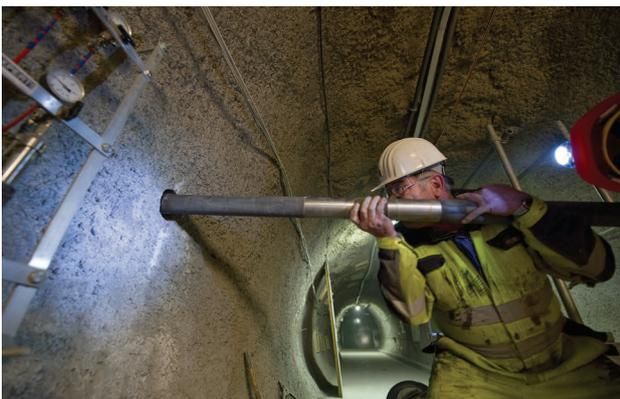
Abbildung 7: Einbau von Messinstrumenten in ein Bohrloch im Untertagelabor Mont Terri (Foto: Mont Terri Projekt, swisstopo).
