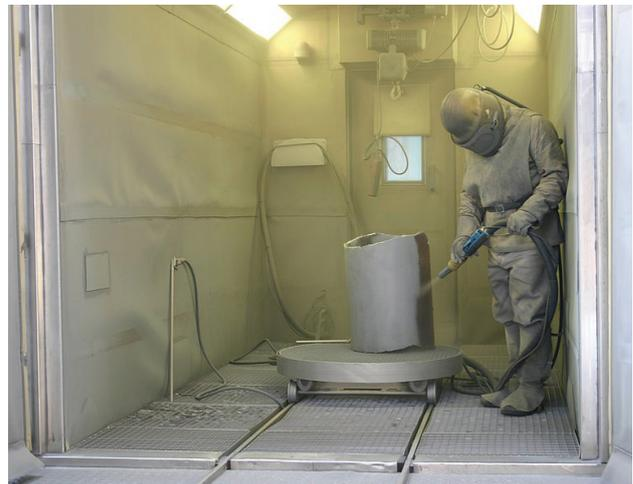
Dekontaminationsarbeiten mittels Trockenstrahlen beim Rückbau einer kerntechnischen Anlage (Foto: EWN Energiewerke Nord GmbH).
