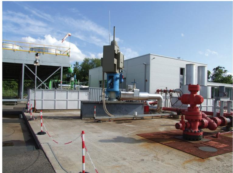
Abbildung 5: Förderbohrung und Reinjektionsbohrung des Geothermiekraftwerks Landau. Blau in der Mitte die Förderbohrung mit der Gestängepumpe, rechts rot die Reinjektionsbohrung, hinten mitte das Pumpenhaus für die Reinjektion
