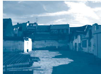
Mondhöfchen nach Abrissarbeiten (Quelle: Quaestio)
