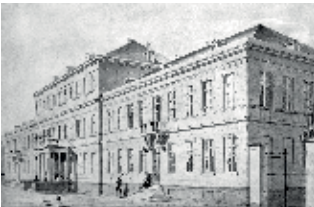
Regierung Köln von Matthias Bierscher, 1839-21. Der Bahnhof Belvedere ist auch Teil der architektonischen Gesamtkonzeption der Rheinischen Eisenbahn.
