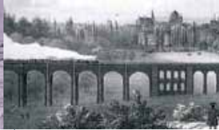
Viadukt Burscheid, im Hintergrund die Stadt Aachen mit dem Domturm.
