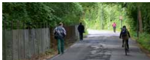
Seite 8 | Gefahrenstelle an der Belvederestraße
