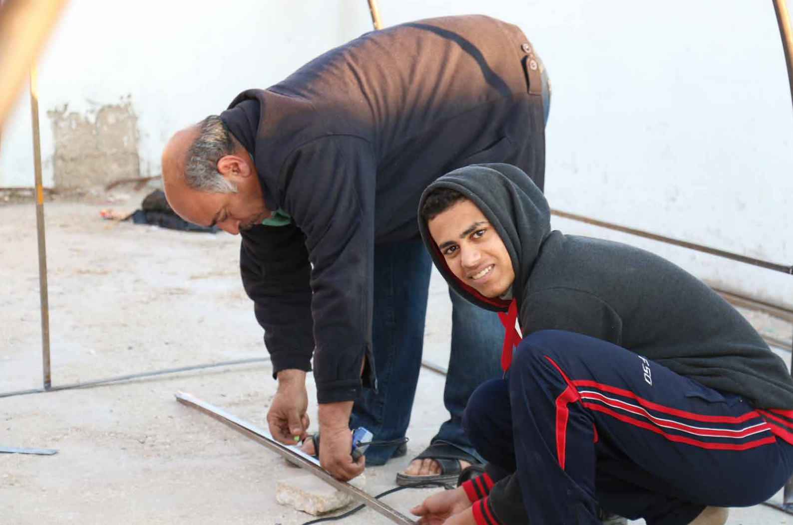
Verschiedene Generationen arbeiten gemeinsam an einer Dachbegrünung
