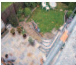
**Terrasse** in Stufenform angelegt und mit einer Einfassung aus Blaubasalt Naturpflastersteinen eingerahmt. Anordnung und Größe der Pflasterplatten als wilder Verband je nach Ebenengröße variierend. Fugen aus durchlässigem festem Fugenmörtel.
