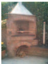
**Rustikaler Grillkamin** aus Feldbrandziegel mit scheidrechtem und Rundbogen individuell gemauert im Außenbereich. Abdeckungen aus portugiesischem Ölschiefer und Innenausmauerung aus Schamotte. Dazu passendes Altstadt-pflaster aus Betonwerkstein und einer gemauerten Heckeneinfassung aus Feldbrandziegel und einer Abdeckung aus portugiesischem Ölschiefer.
