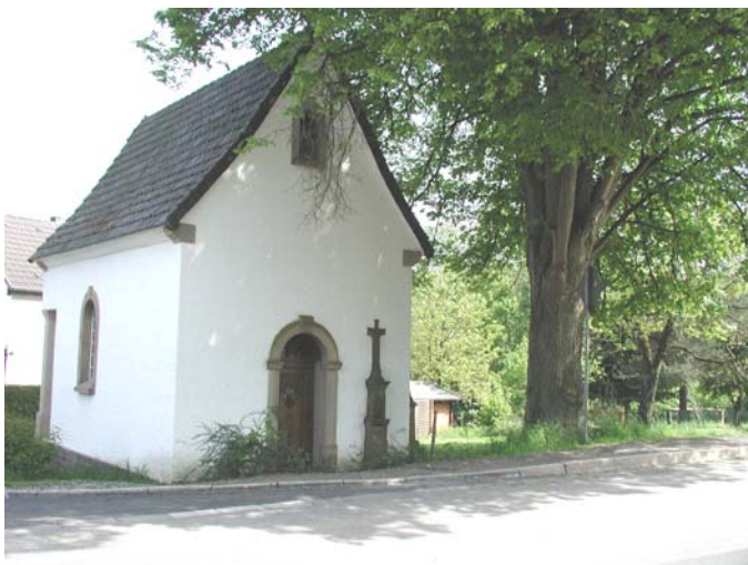
Kapelle in Oberdreisbach
