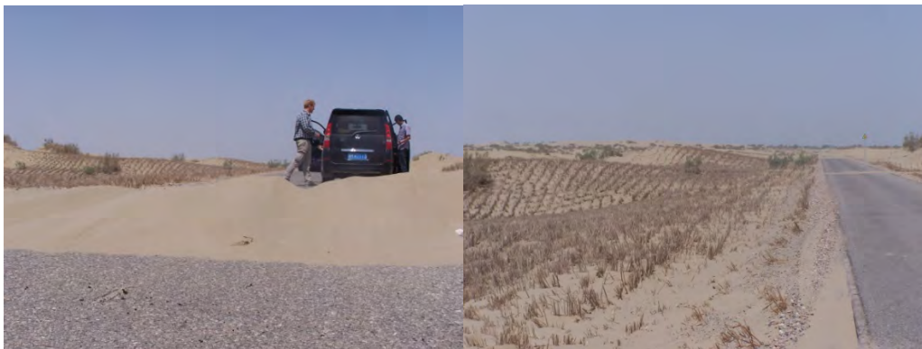
Abb.3: Sandverwehung auf einer Nebenstraße (l) und Strohverbauungen als Schutzmaßnahme (r) [Fotos: Betz 2013]
