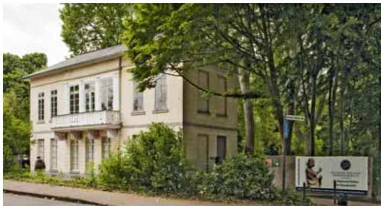
Nord-östliche Schaufassade des Empfangsgebäudes.
