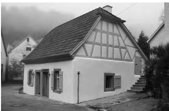
Das Wasch- und Backhaus in Widdern (BW) vor und nach der Restaurierung durch ein ehrenamtliches Team
