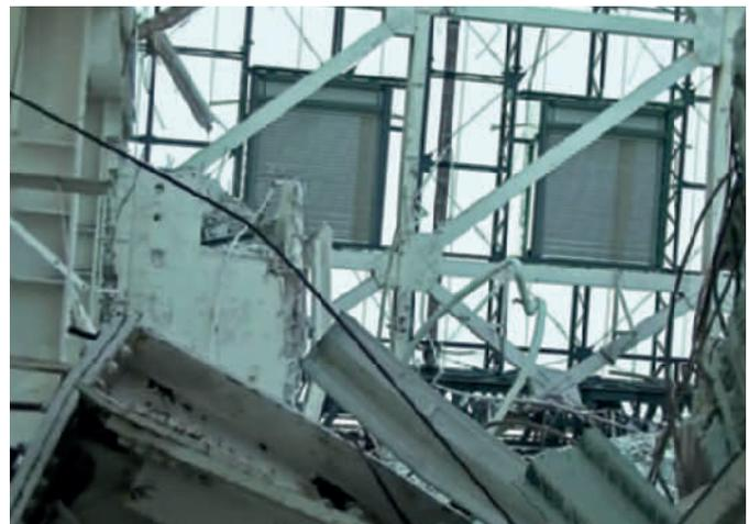
Abb. 6.29: Bildaufnahmen aus dem Einsatz eines Erkundungsballoons im Oktober 2012: Blick durch den Bedienflur von Block 1 (Quelle: TEPCO).
