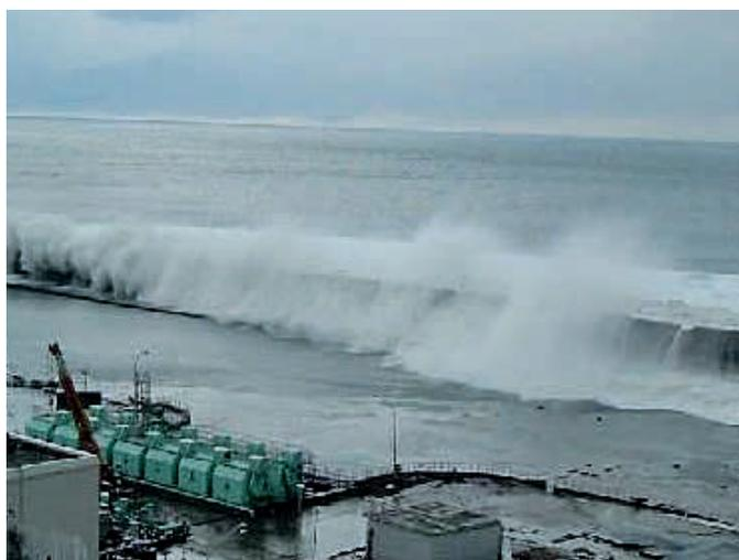
**Abb. 3.12:** Überflutung des seeseitigen Teils des Anlagengeländes durch erste Tsunamiwellen, aufgenommen durch eine Überwachungskamera (Quelle: TEPCO).
