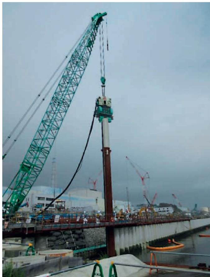
Abb. 6.14: Setzen der letzten Stahlrohre zur Fertigstellung des Grundwasser-Absperrbauwerks (Quelle: TEPCO).
