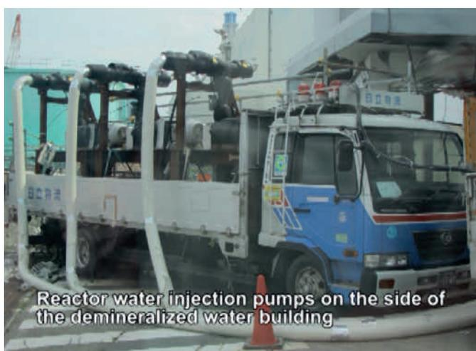
Abb. 6.1: Reaktoreinspeisepumpen und Ersatzaggregate (Quelle: TEPCO).
