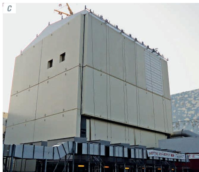
Seit Ende 2015 laufen die Vorbereitungen für den Bau der Einhausung und der BE-Handhabungseinrichtungen. Der Aufbau der Originalteile für die Einhausung wurde bereits vorab im nicht kontaminierten Onahama Bay trainiert. Der Aufbau vor Ort soll im März 2016 beginnen. Mit der Bergung der Brennelemente aus dem BE-Lagerbecken ist laut TEPCO Anfang 2018 zu rechnen.
