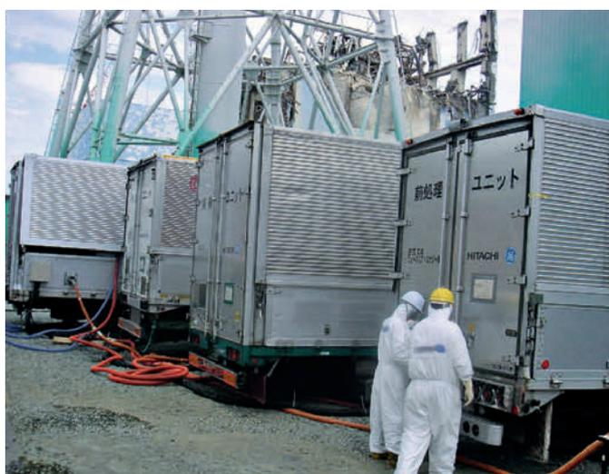
Abb. 6.4: Mobile Anlagen zur Entsalzung des Wassers in den BE-Lagerbecken (Quelle: TEPCO).
