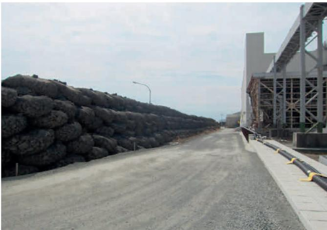
Abb. 6.2: Schutzwall gegen Tsunamis (Quelle: TEPCO).
