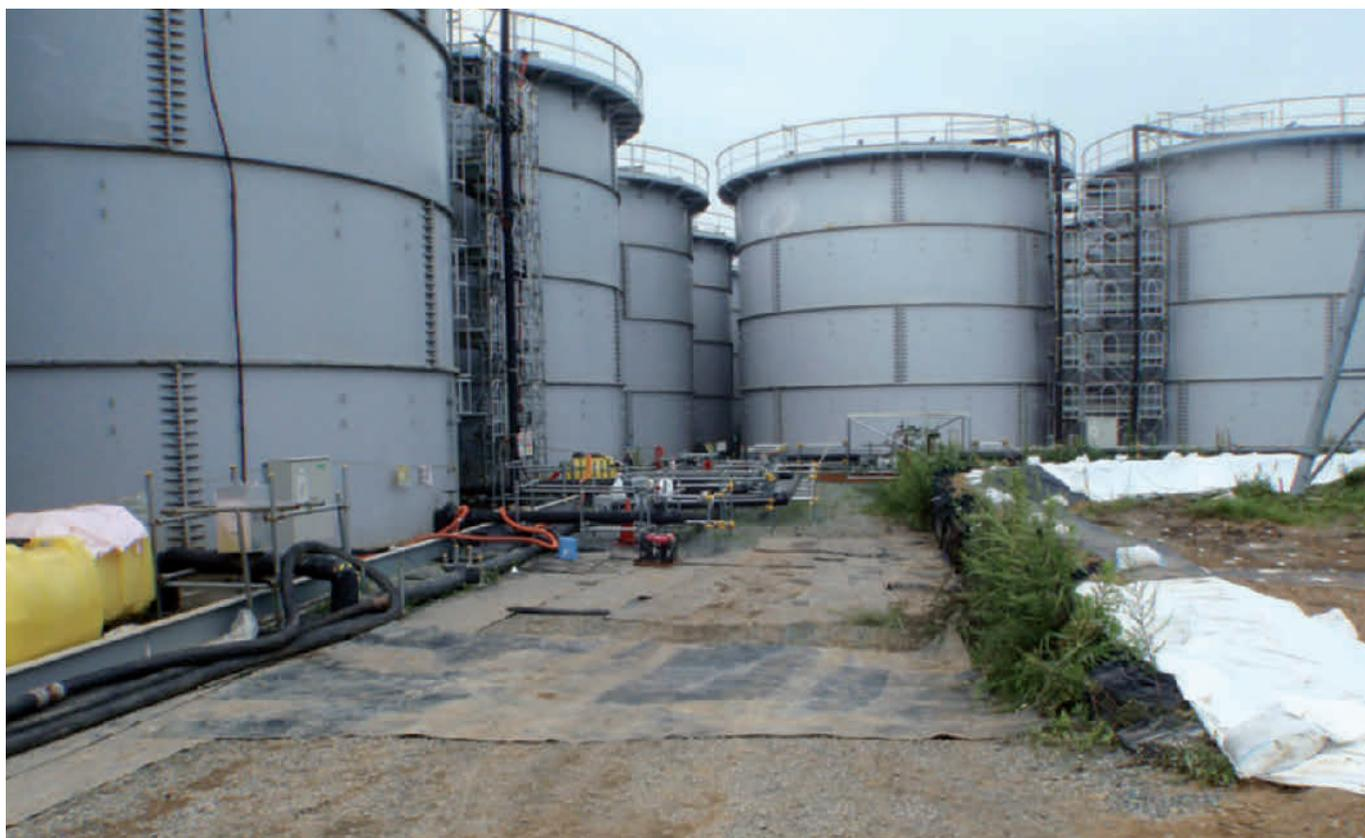
**Abb. 3.35:** Tanks des Aufstellbereichs H4, in dem sich die mit INES 3 eingestufte Leckage ereignete. Rechts im Bild ist ein aus Sandsäcken errichteter Wall zu erkennen, mit dem im Fall weiterer Leckagen eine weitere Verbreitung des kontaminierten Wassers verhindert werden soll (Quelle: TEPCO).
