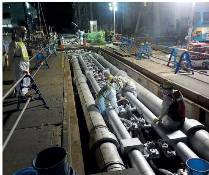
Abb. 6.15: Montage der Kältemittelleitungen zur Errichtung des sog. Eiswalls (Quelle: TEPCO).
