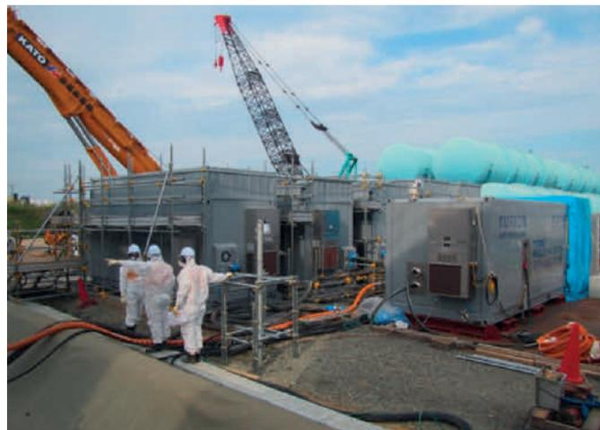
Abb. 6.6: Mobile Strontium-Reinigungsanlagen neben Tanks zur Zwischenlagerung kontaminierter Wässer (Quelle: TEPCO)
