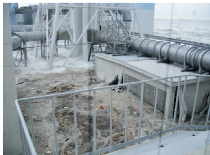
**Abb. 3.27 und 3.28:** Eintreffen des Tsunami am Abfallbehandlungsgebäude, unmittelbar beim Block 4, aufgenommen ca. 15:42 Uhr (Foto links) und etwa eine Minute später (Foto rechts).
