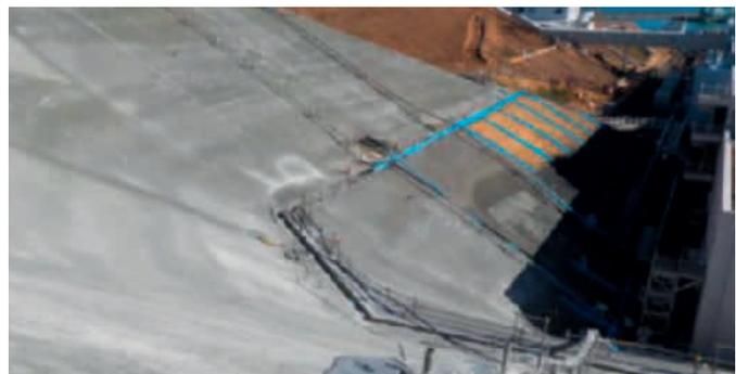
**Abb. 6.18:** Beispiel für die Flächenversiegelung auf dem Anlagengelände; oben nach der Rodung, unten nach der Versiegelung (Quelle: TEPCO).
