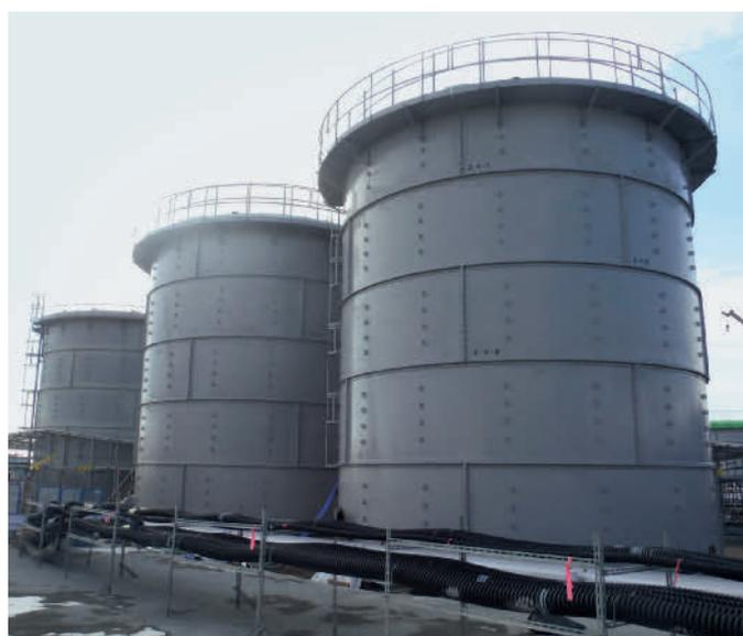
Abb. 6.12: Verschraubte Tanks mit 1.000 m<sup>3</sup> Volumen zur Lagerung von kontaminiertem Wasser (Quelle: TEPCO).
