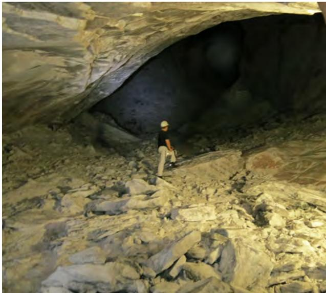
**Abb. 3.1.2** Blick in den Eingangsbereich des Kavernenhohlraums nach dem CO<sub>2</sub>-Ausbruch vom 01.10.13 in dem 100.000 m<sup>3</sup> CO<sub>2</sub> im superkritischen Zustand 20 Mio. Jahre eingeschlossen waren
