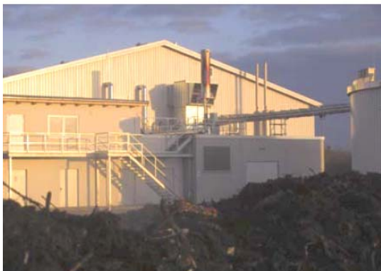
Trockenfermentationsanlage in Erfurt
