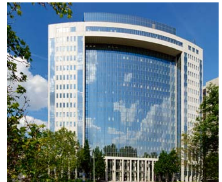
Cofely sorgt für die energetische Optimierung des Centurion-Gebäudes in Frankfurt.
