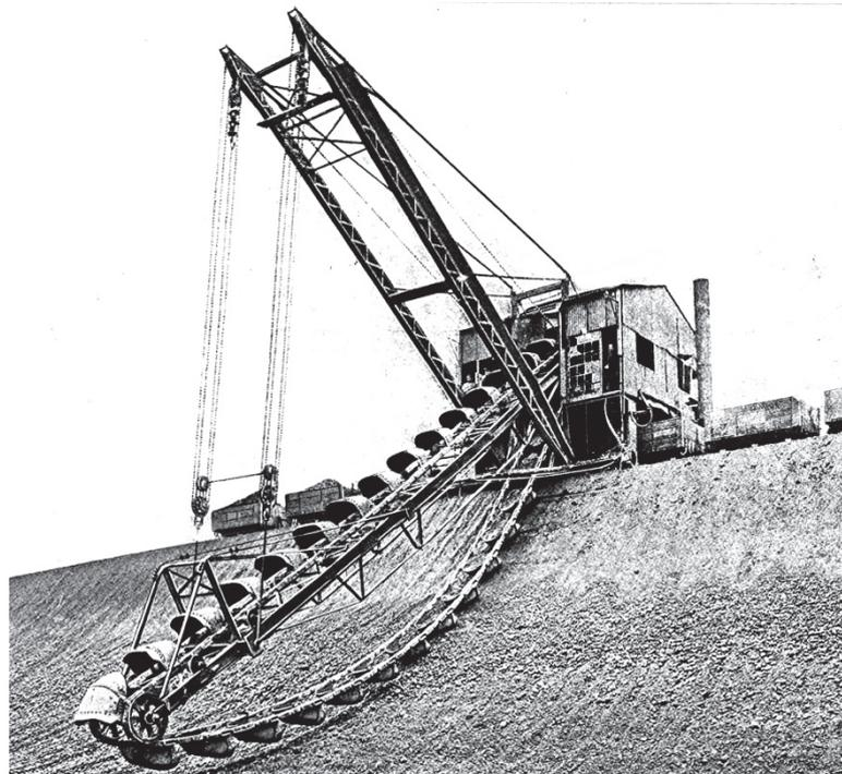
**Bild 27: Dampfgetriebene Eimerkettenbagger im Abraum** (nach Klein 1915)
