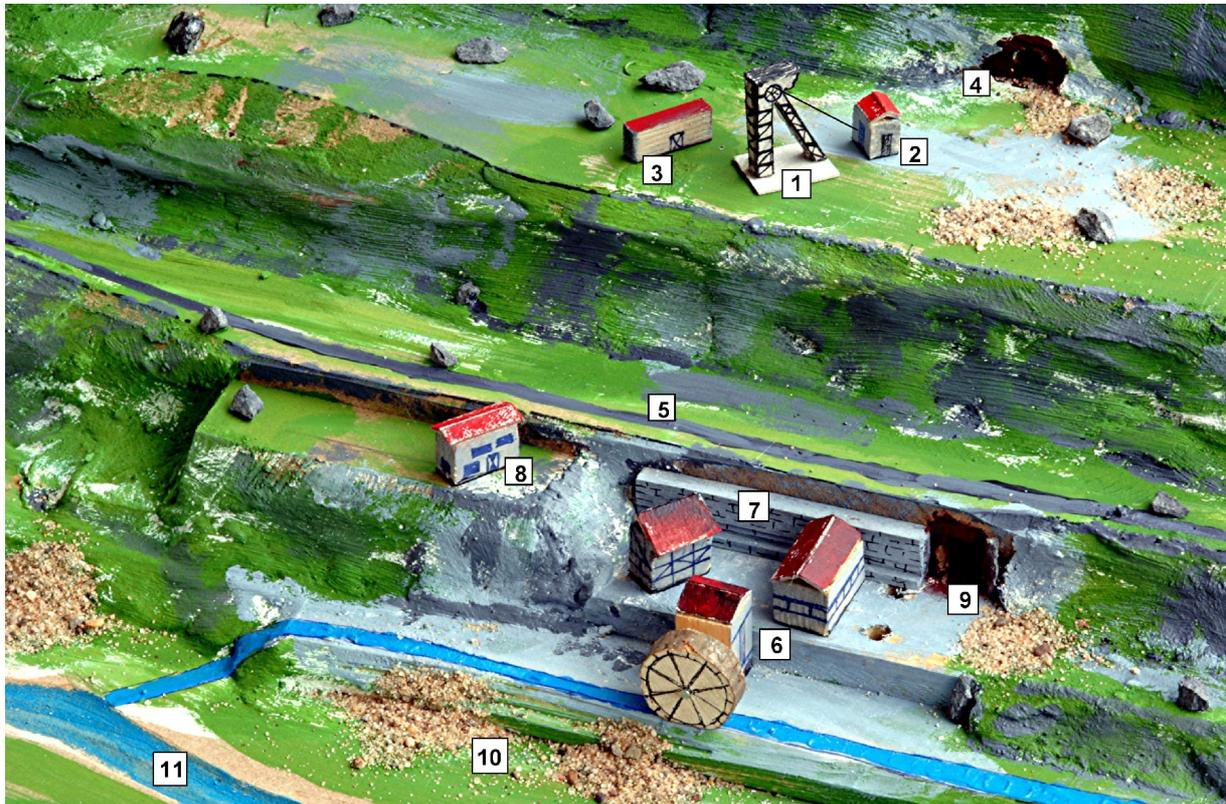
**Bild 36 a: Grube Ziethen um 1860 im Modell mit Schacht 1, Aufbereitungsanlage und Stollen, die Zahlen im Bild bedeuten:**
