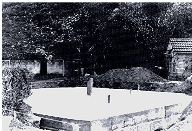
**Bild 52: Sanierung Schacht 3** (s. Bild 51, Nr.1)<sup>1</sup>; links: Freilegung der alten Schachtabdeckung; rechts: neuer Schachtdeckel 1975
