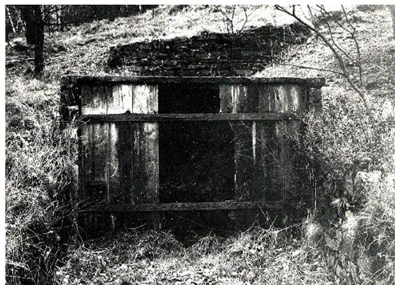
**Bild 53: Stollen 2a** (s. Bild 51 Nr. 3)<sup>2</sup> links: Stollen innen abgemauert; rechts: alter Holzverschlag zum Stolleneingang
