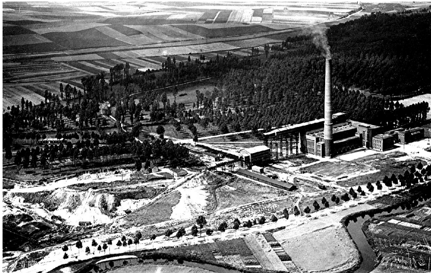
Bild 38: Kraftwerk Frimmersdorf nach Inbetriebnahme im Jahre 1926 52
