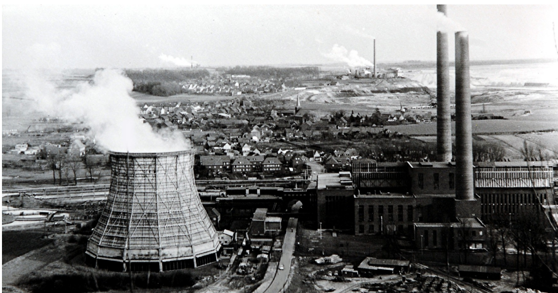
Bild 116: Kraftwerk Frimmersdorf 1 nach den Kapazitätserweiterungen auf 90 MW im Jahre 1950 mit zweitem Schornstein und dem Bischof-Kühlturm, im Hintergrund die Brikettfabrik Prinzessin Victoria in Neurath 172
