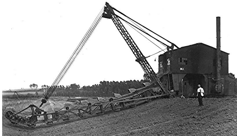
Bild 45: Dampfangetriebener Eimerkettenbagger im Jahre 1929 im Abraumbetrieb 59
