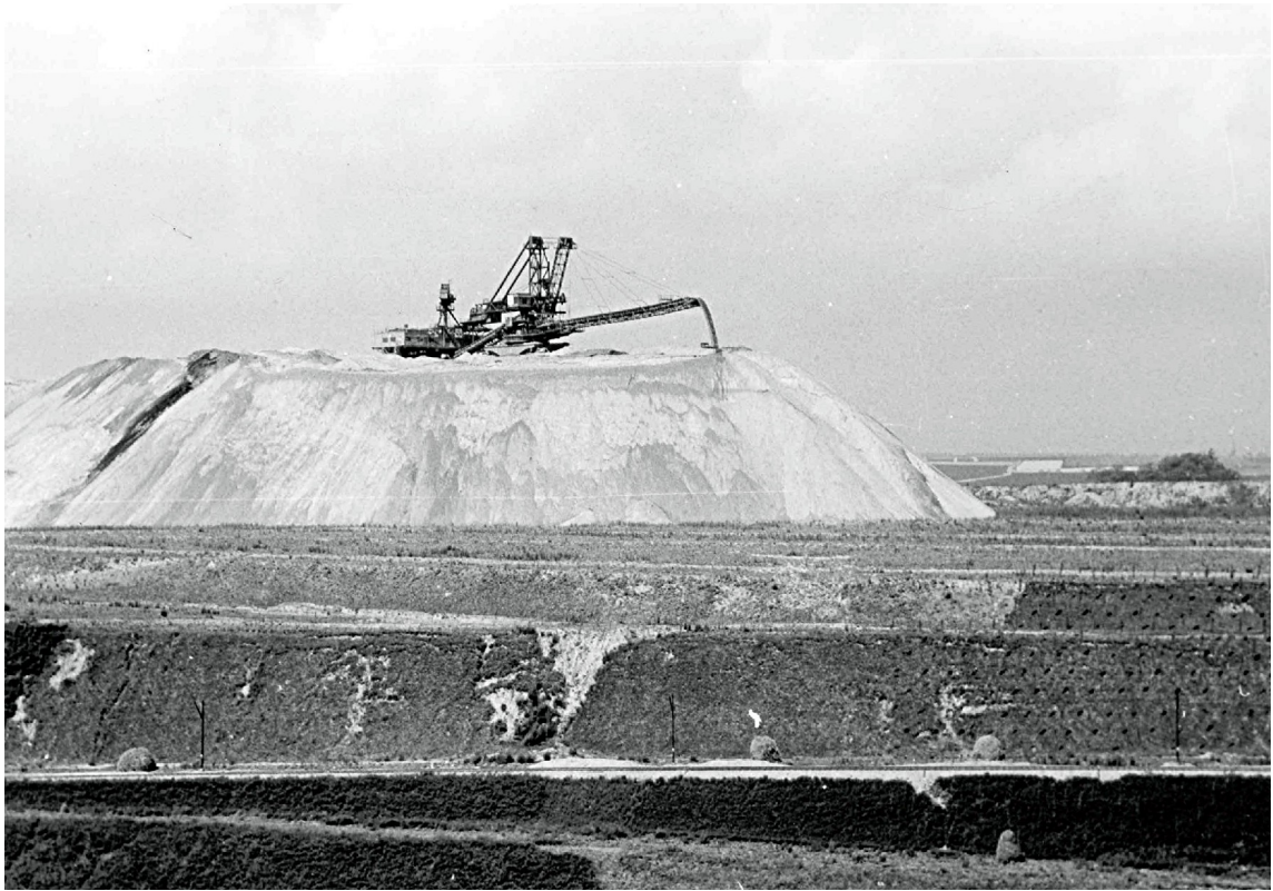
Bild 86: Abraumverkipfung auf der Halde Vollrath mit dem Absetzer Nr.83 im Jahre 1967 119
