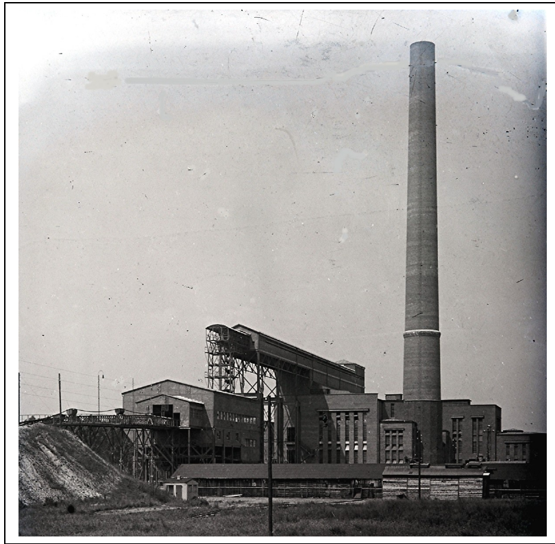
Bild 115: Kraftwerk 1 in Frimmersdorf im Jahre 1926, links auf der Rampe die Einfahrt der Kettenbahn aus der Grube Walter in das Werk 170
