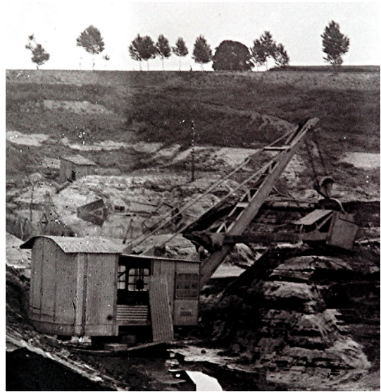
Bild 32 : Erster Löffelbagger für die Kohlegewinnung in der Grube Walter, links: Transport in die Grube, rechts: Baggereinsatz vor Ort 44
