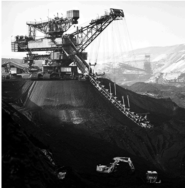
Bild 61: Kohlegewinnung im Tagebautiefsten (Wiedenfelder Graben) im Jahre 1970 mit dem Eimerkettenbagger Nr. 106 88
