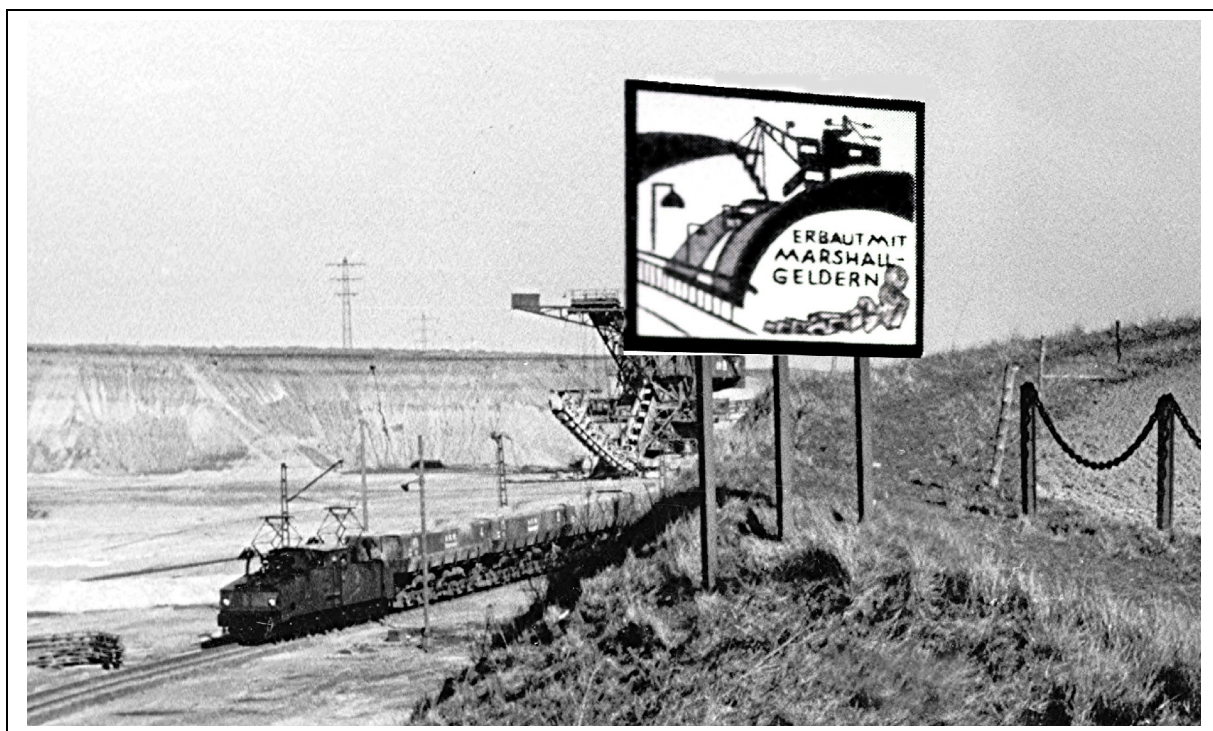
Bild 74: Tafel am Tagebau Frimmersdorf Westfeld mit dem Hinweis, dass der Anschluss des Tagebaus mit Marshallplangeldern erfolgt 102
