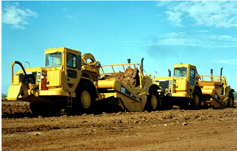
Bild 118: Schürfzüge bei den Erdbauarbeiten für das Kraftwerk 2 in Frimmersdorf 174
