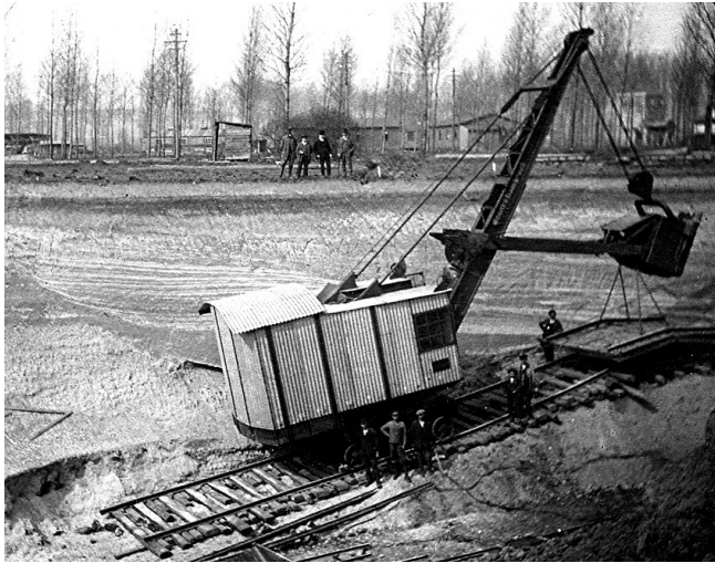
Bild 32 : Erster Löffelbagger für die Kohlegewinnung in der Grube Walter, links: Transport in die Grube, rechts: Baggereinsatz vor Ort 44
