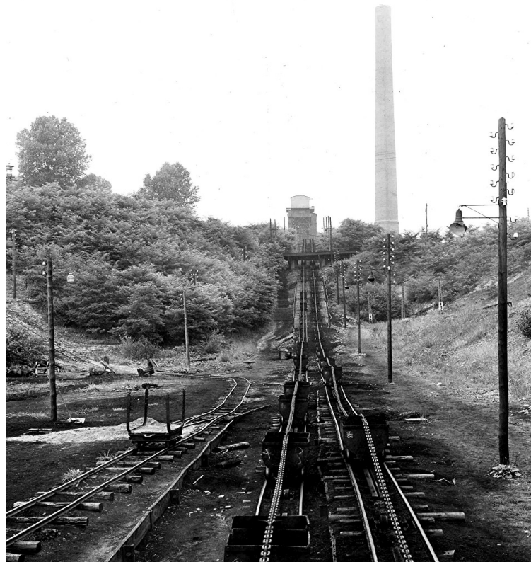
Bild 31: Kohleförderung aus der Grube zum Kraftwerk mit einer Kettenbahn 43
