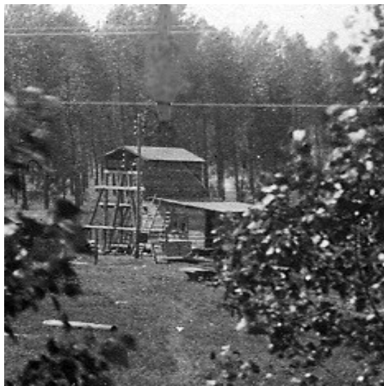
Bild 34: Schacht am Tagebaurand zum Abpumpen des in der Grube anfallenden Wassers 48
