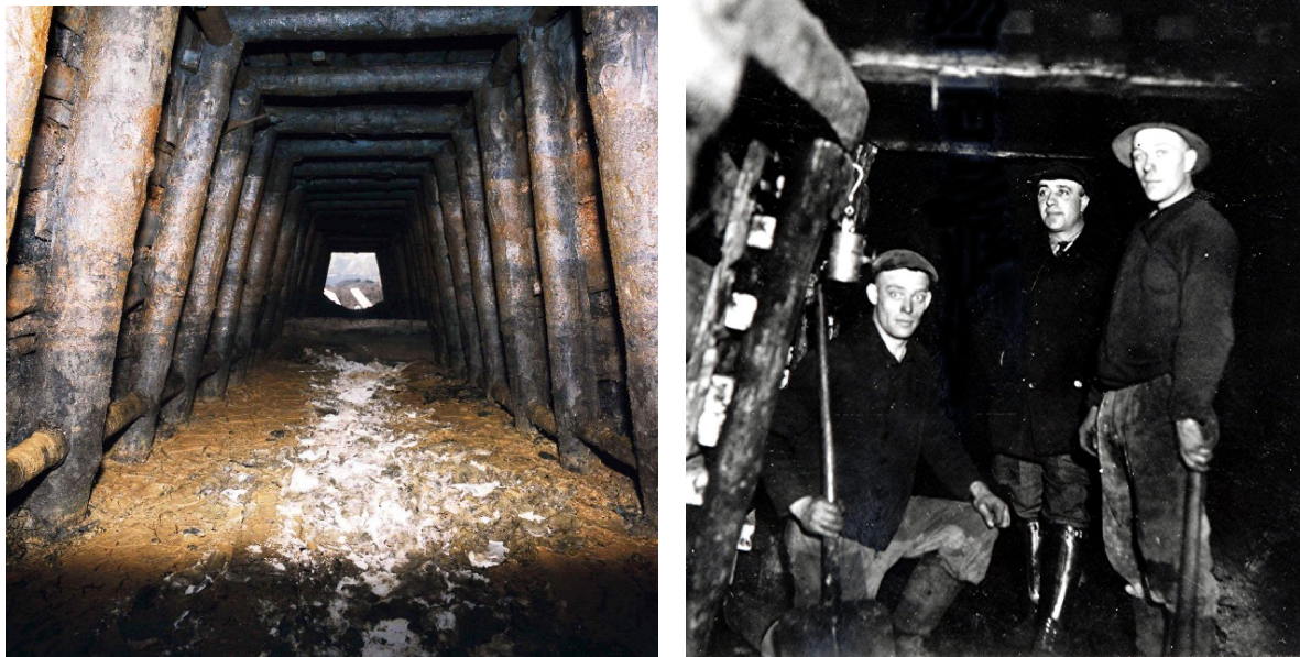
Bild 35: Stollen (Entwässerungstrecken) zum Ableiten des Grubenwassers 49
