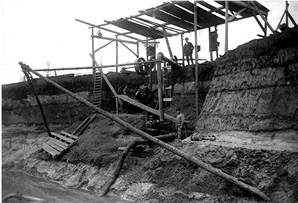
Bild 37: Erste Pumpanlagen in der Grube Walter im Jahre 1920 51
