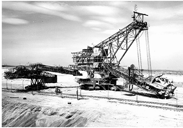
Bild 79: Schaufelradbagger Nr.75 im Tagebau Westfeld 1955 112
