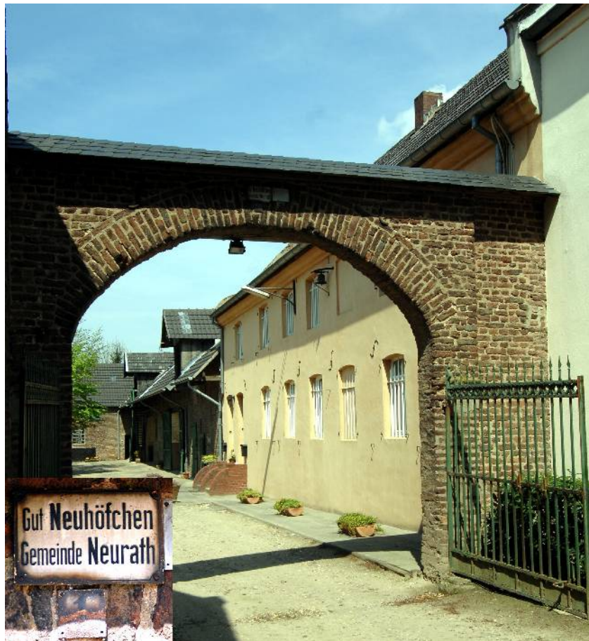
Bild 22: Einfahrt in das Gut Neuhöfchen im Jahre 2008 mit Ortsschild im Torbogen (Ortsschild unten links eingeblendet), rechts das Haupthaus
