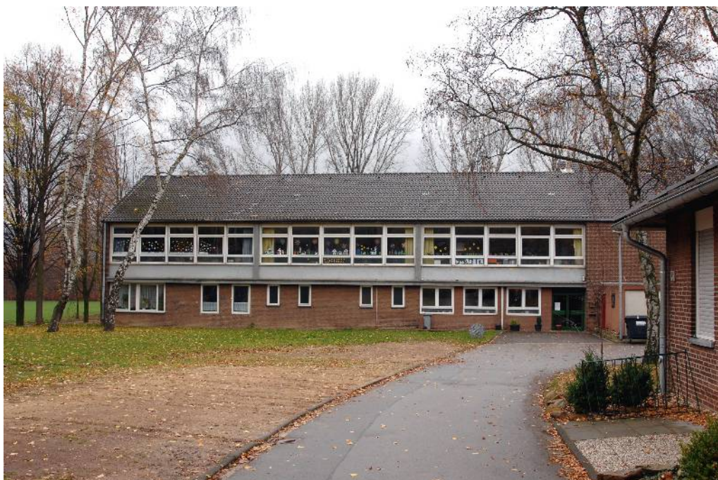
Bild 13: Schule 4 an der Frimmersdorfer Straße 114 ab 1958
