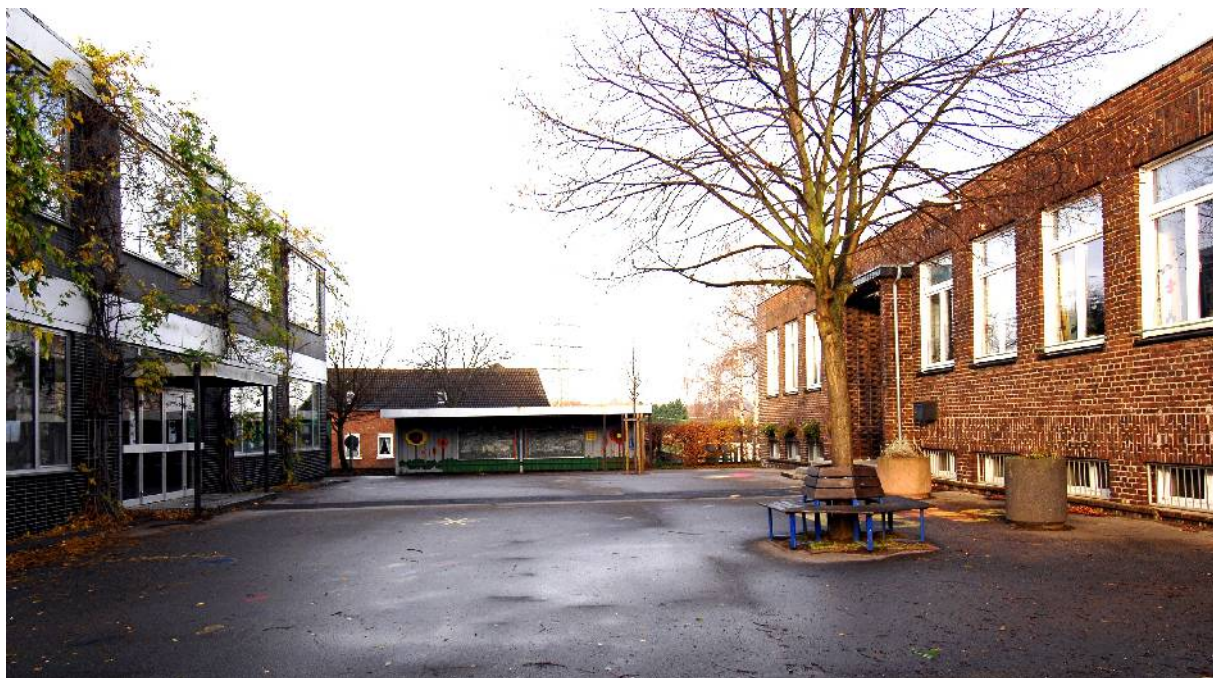
Bild 15: Grundschule Frimmersdorf, Josef-Lützenkirchen-Str. 39 im Jahre 2008 (rechts der Klinkerbau aus dem Jahre 1928, links der Containeranbau) Der Klinkerbau hatte ursprünglich ein Giebeldach. Dieses wurde nach Schäden abgetragen und durch ein Flachdach ersetzt.
