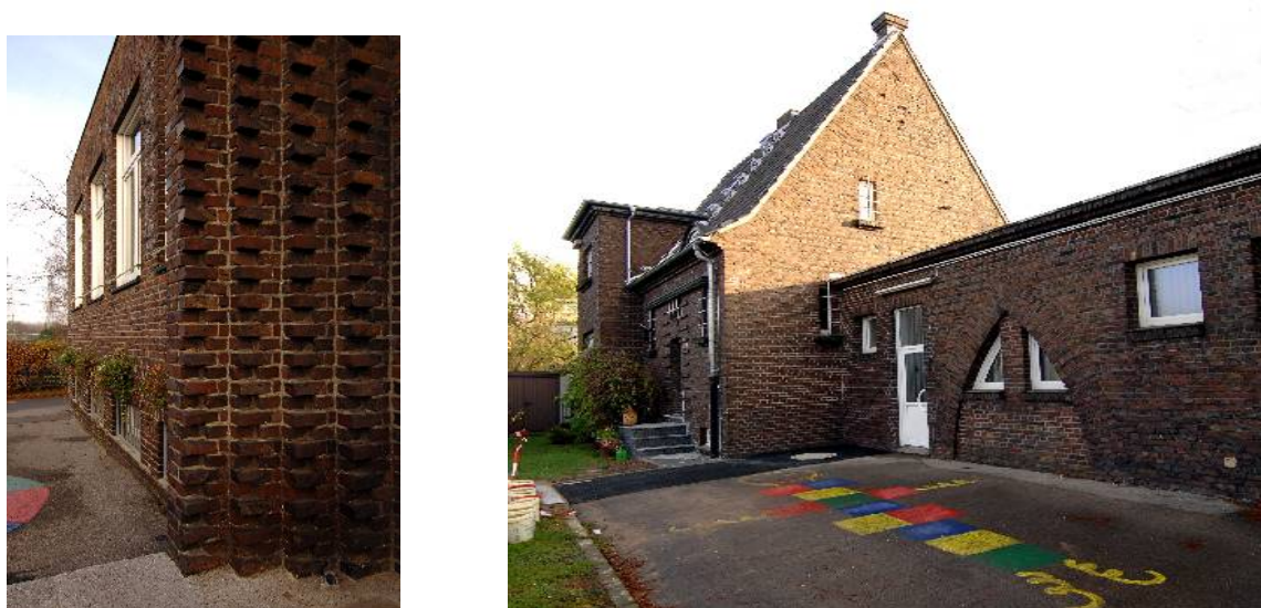
Bild 16: Grundschule Frimmersdorf (erbaut 1928) im Jahre 2008 (links Eingangsbereich, rechts die Lehrerwohnung)
