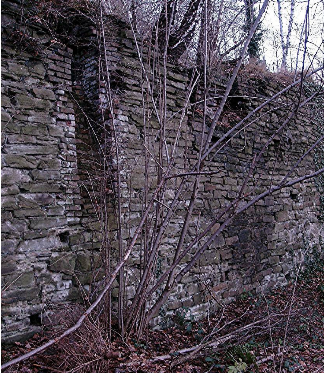
Bild 24: Stützmauer an der ehemaligen Aufbereitungsanlage im Jahre 2006
