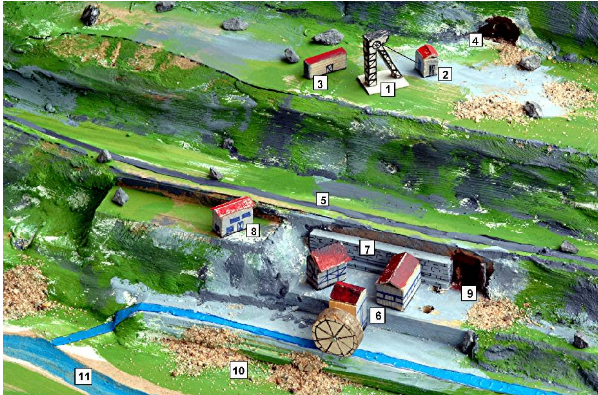
Bild 21: Grube Ziethen um 1860 im Modell mit Schacht 1, Aufbereitungsanlage
