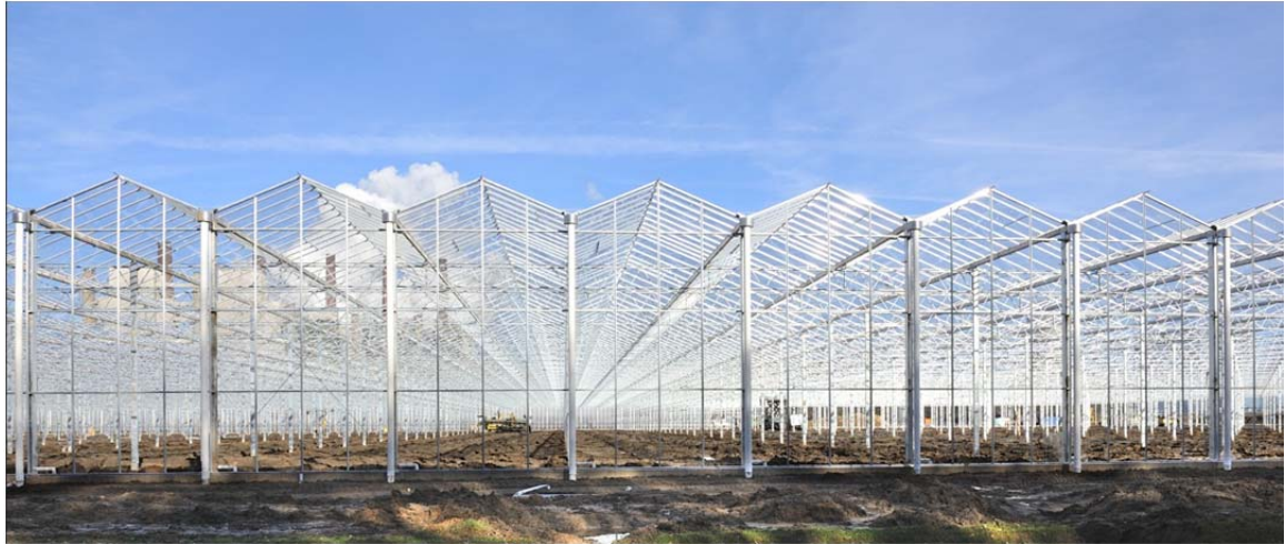
Bild 2.2: Die Konstruktion des Gewächshauses. Im Hintergrund links das Kraftwerk Neurath, von wo aus das Gewächshaus beheizt wird.
