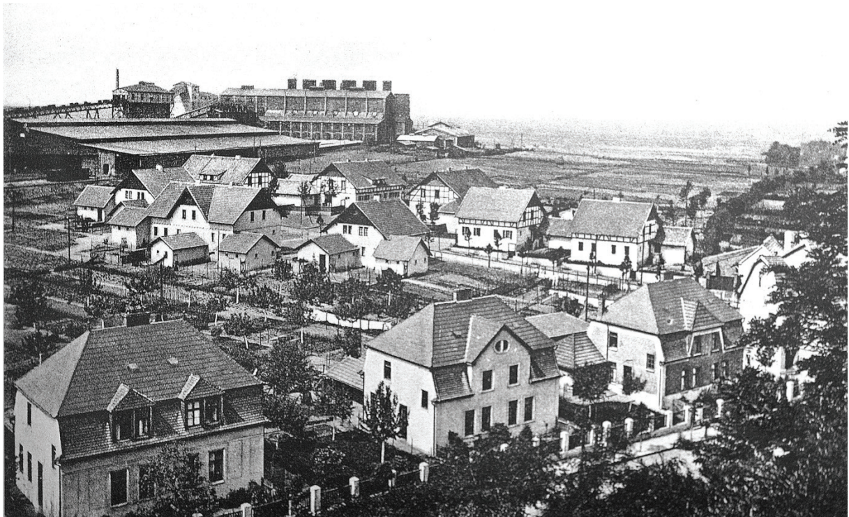
Bild 6: Mit Ziegeln aus der Ringofenziegelei wurden in Neurath an der Gürather Straße und in der Viktoriastraße in den Jahren 1918-1921 Wohnhäuser errichtet. Im Vordergrund die großen Häuser stehen an der Güratherstrasse, die kleineren Häuser dahinter in der Viktoriastraße. Im Hintergrund die Brikettfabrik Prinzessin Viktoria. 14
