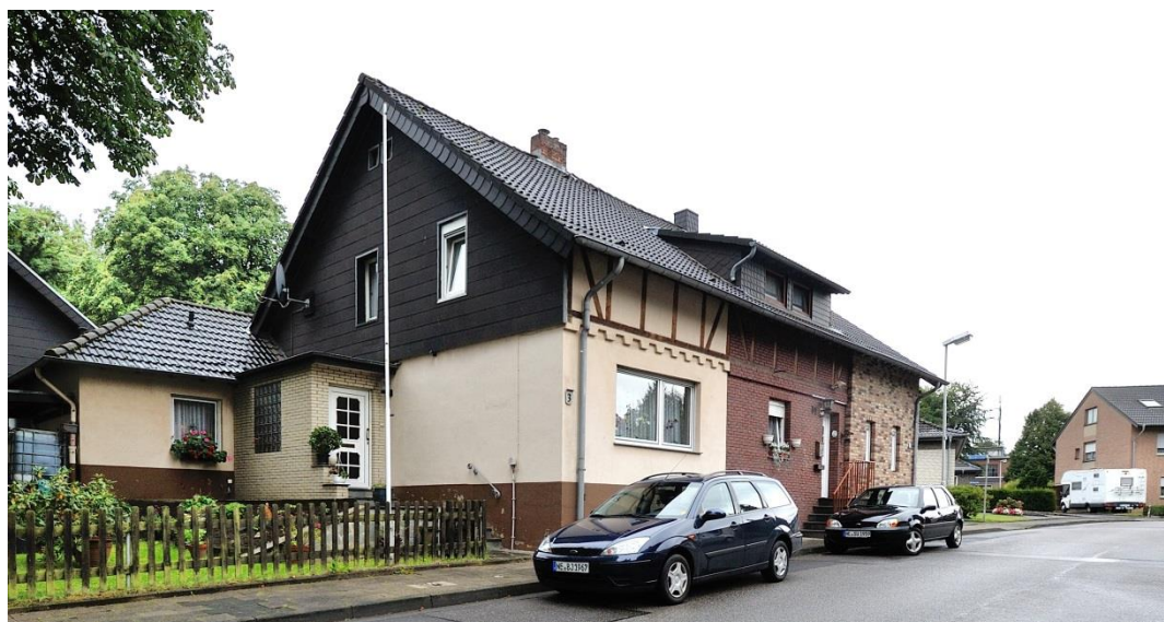
Bild 30: Die alten Siedlungshäuser in der heutigen Falkenstraße Nr. 3 (vorn) und Nr. 5 (Mitte). Nr. 7, das dritte Haus im Verbund, ist ein neuerer Anbau. Im Hintergrund (auf dem Bild rechts) Bebauung aus neuerer Zeit.
