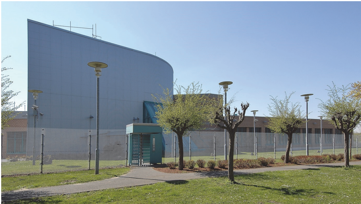
Bild 28: Rechenzentrum der RWE AG. Es steht genau an der Stelle, wo sich früher die Hauptverwaltung befand.
