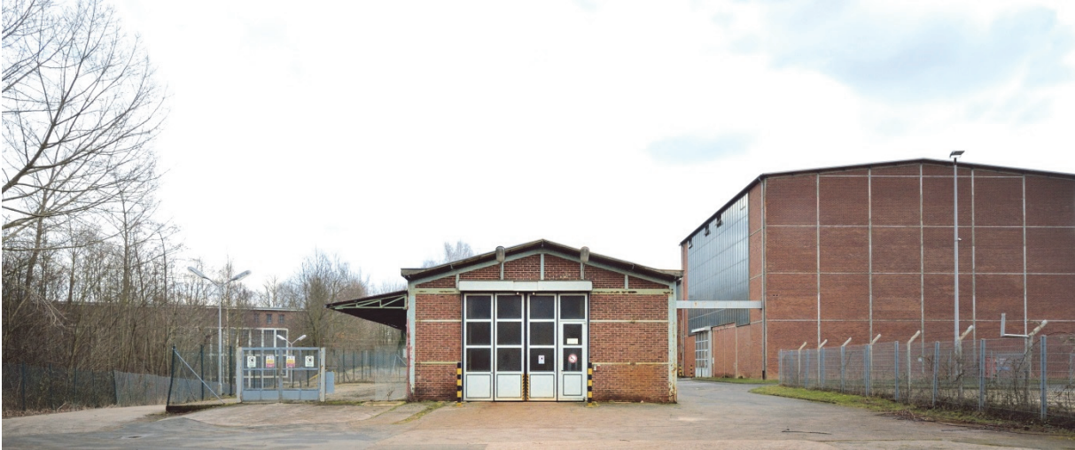
Bild 16: Lokschuppen mit Einfahrtstor, rechts dahinter die Hauptwerkstatt
