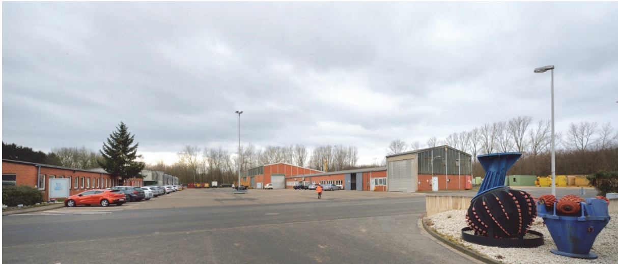
Bild 20: Servicestützpunkt Bohr- und Wasserwirtschaft an der Buchholzer Straße
