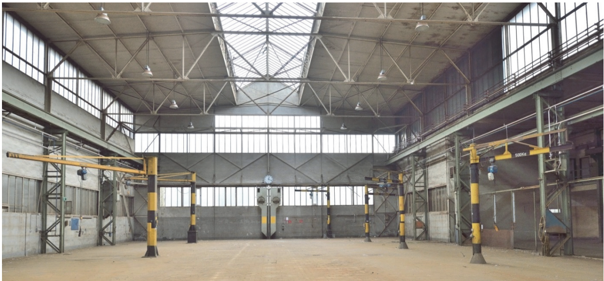
Bild 13: Haupthalle mit Laternendach
