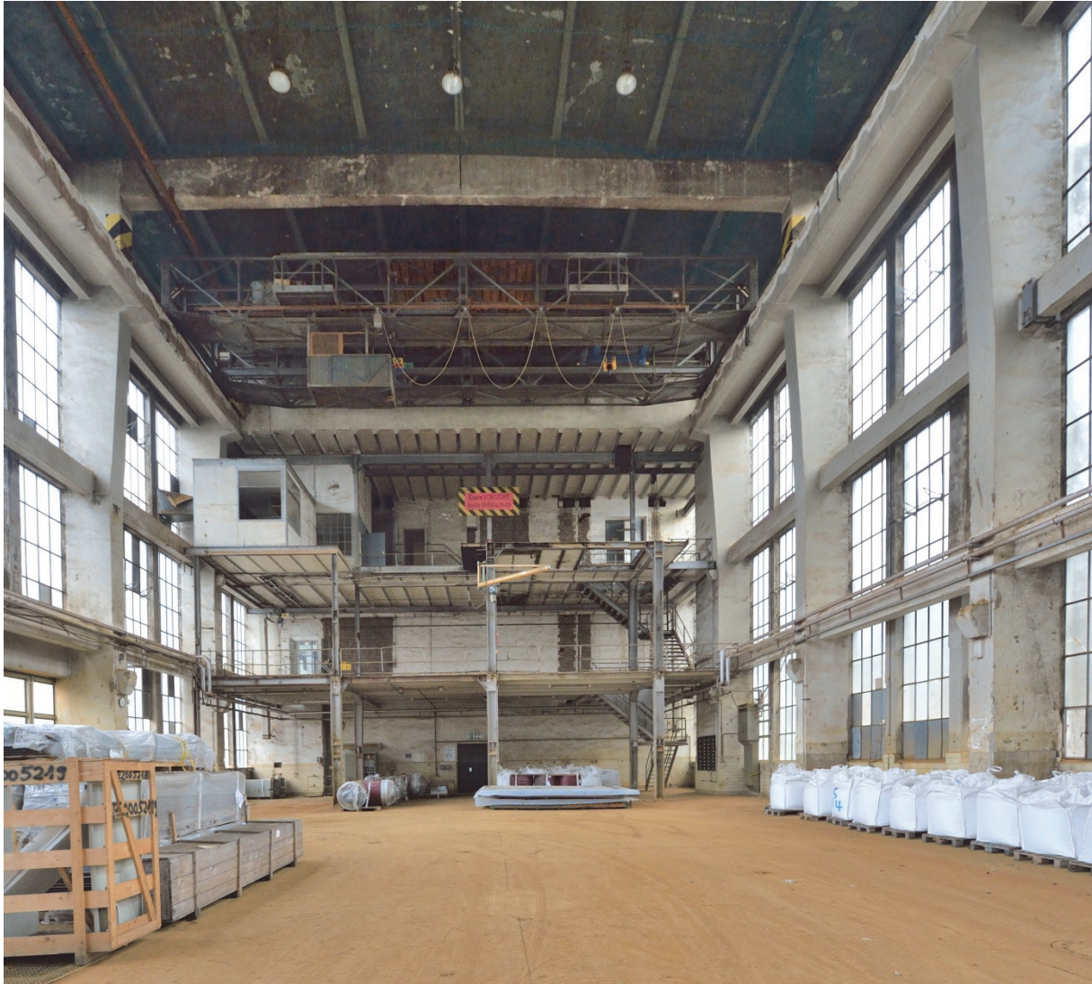
Bild 10: Das Innere des Nassdienstes im Jahre 2015. Die Maschinen sind zum Großteil demontiert. Abmessungen des Gebäudes: L=83,6m, B = 22,7 m, H = 20,2 m
