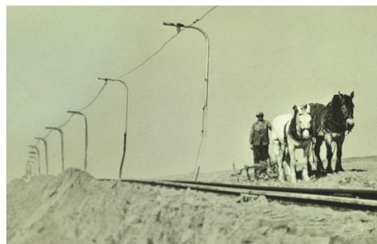
Bilder 19.1 (links) und 19.2 (rechts): Bei der landwirtschaftlichen Rekultivierung im Zuge des Lössbodenauftrags wurde neben der Verkippung mit einem Absetzer (siehe Bild 18) auch mit der Pflugkippentechologie gearbeitet.
