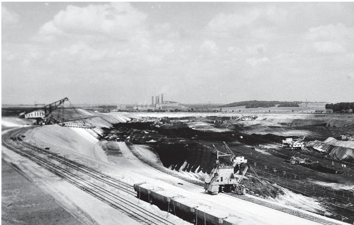
Bild 17: Tagebau Neurath im Jahre 1957. Im Hintergrund das Kraftwerk Frimmersdorf. Im Einsatz auch der seinerzeit größte Eimerkettenbagger der Welt, der Bagger DS 1100.
