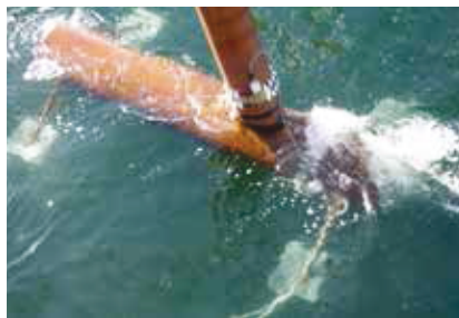
Abbildung 18: Test des Unterwasserknotens im Offshore-Windpark Baltic 1
